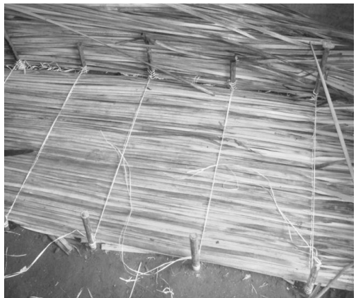
Fig. 31. Entramado en la última etapa y cosido con hilos
