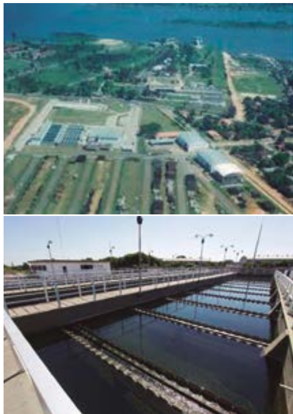
Figura 1. Planta de tratamiento de agua en Viñas Cue
